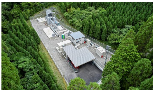
グリーン水素製造実証プラント全景
