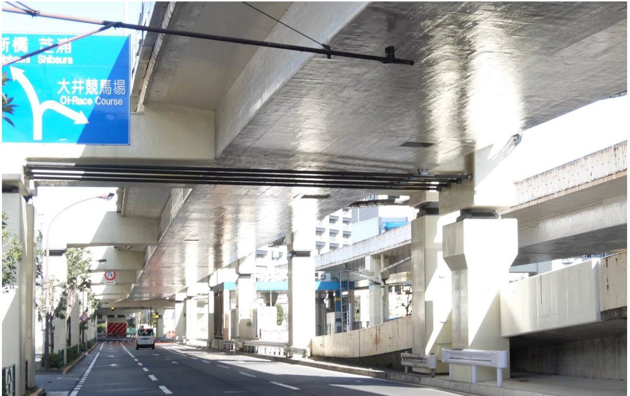
首都高速1号羽田線 勝島地区橋梁 新設橋脚と連続化された桁を臨む
