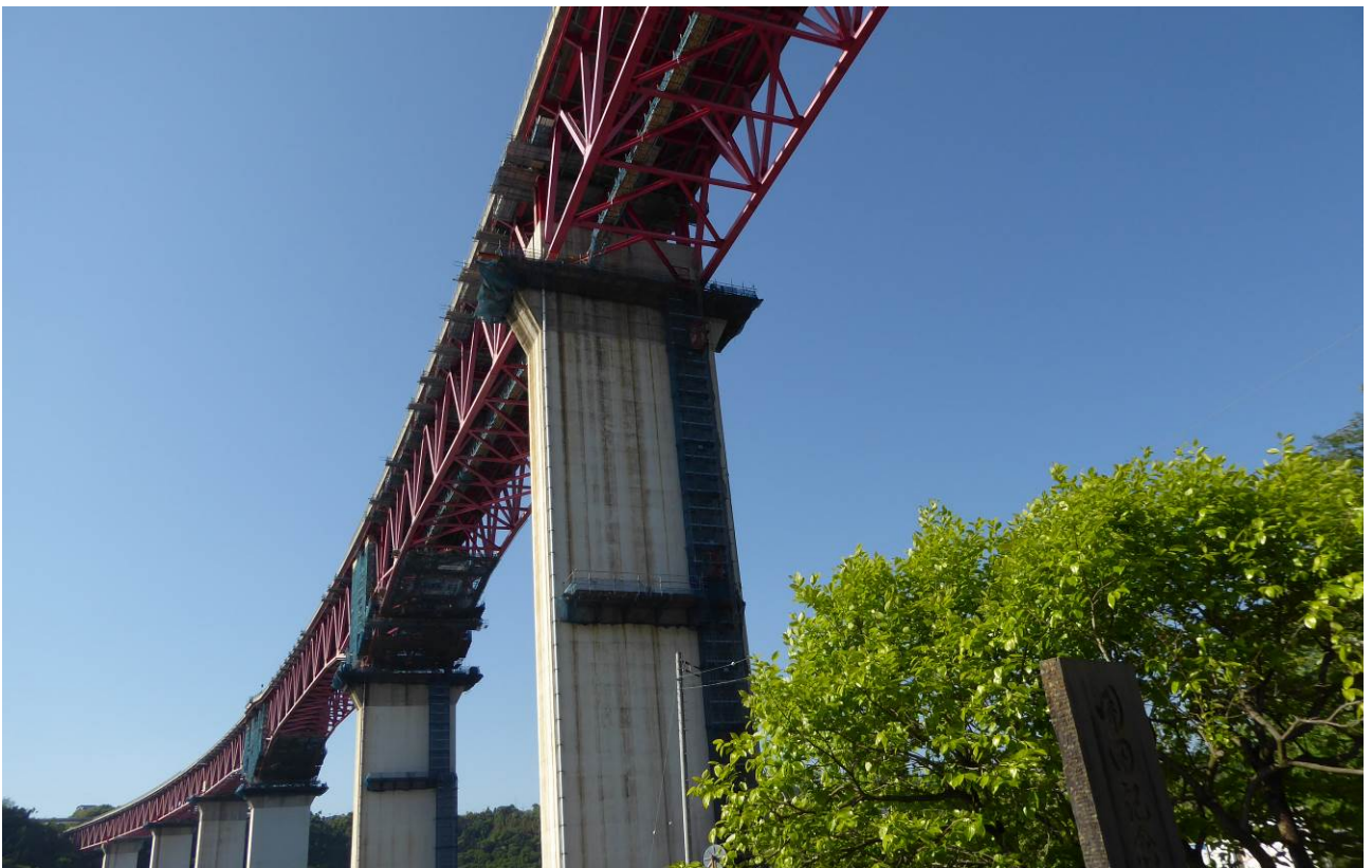
関越自動車道 片品川橋 耐震補強工事最終段階
